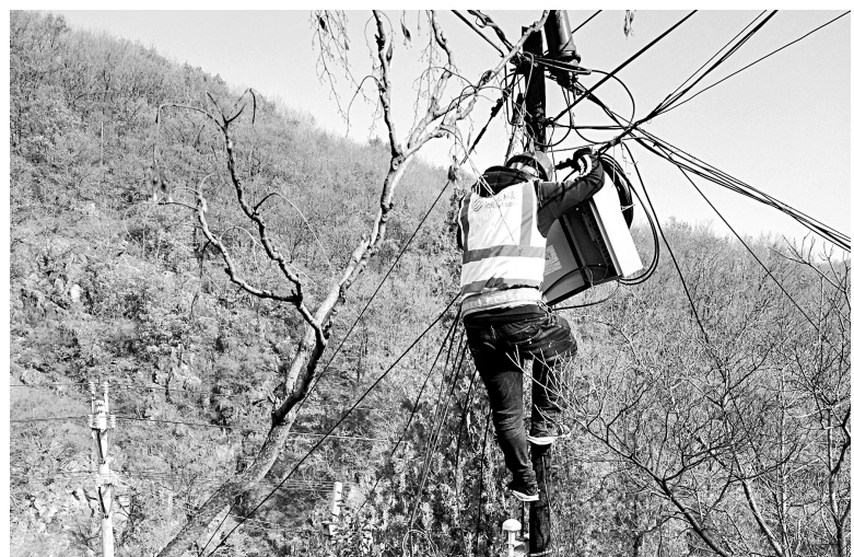
林州市原康镇九龙村双庙自然村地处太行山深山区,是当地重点扶贫对象,长期以来无线信号弱,与外界沟通成了大问题。为帮助双庙村早日脱贫,近日,中国移动公司林州分公司建设了当地唯一的通信基站,解决了双庙村群众通信难的问题,结束了双庙村不通电话的历史。 图为工程施工人员正在山坳调试新装设备。(新乐摄)
