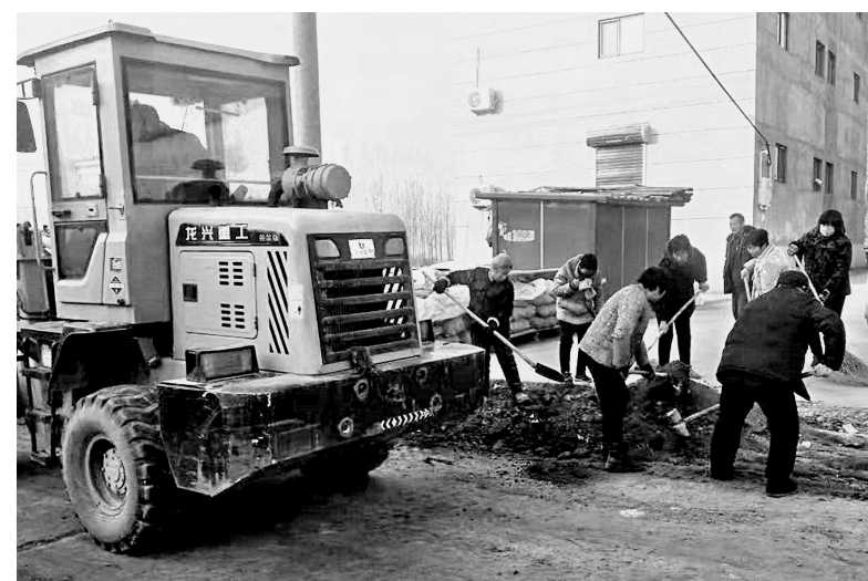
为切实改善农村人居环境,进一步提升群众幸福指数,韩陵镇全面扎实开展农村人居环境整治工作,在全镇上下掀起整治农村人居环境新高潮。图为12月19日,镇区群众在硬化路面。
