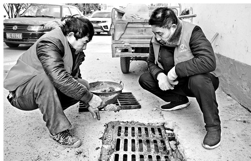
兴泰苑小区属于老旧小区,破损污水井盖较多,带来安全隐患。12月12日,光华路街道兴泰苑社区工作人员勘察现场,了解情况,并组织辖区志愿者更换水表井盖5个、污水井盖1个、雨水井盖1个,消除了安全隐患,得到了辖区居民的一致好评。图为工作人员更换井盖。(本报记者 刘斐 摄)
