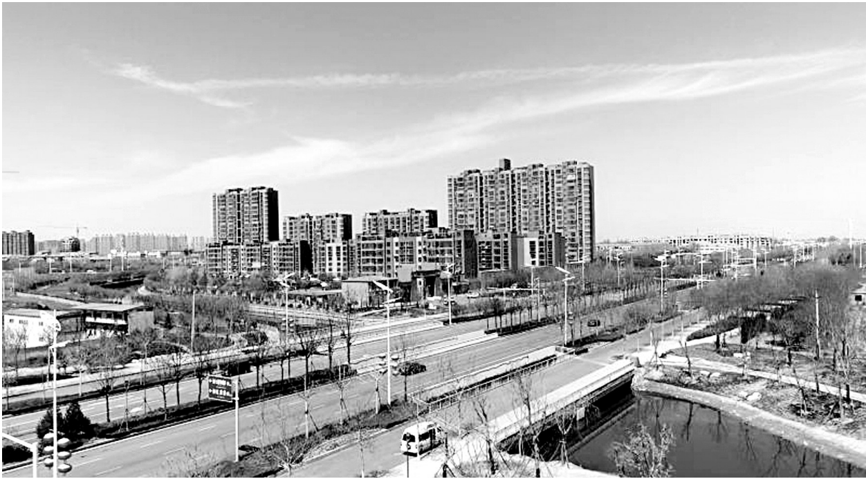
四通八达的安阳县(示范区)道路(刘好杰 摄)
