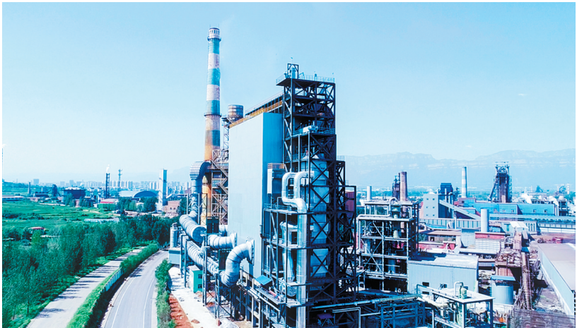
投入运行的凤宝烧结机烟气活性炭脱硫脱硝环保项目(凤宝公司提供)
