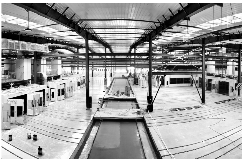
钣喷产业园喷漆车间
