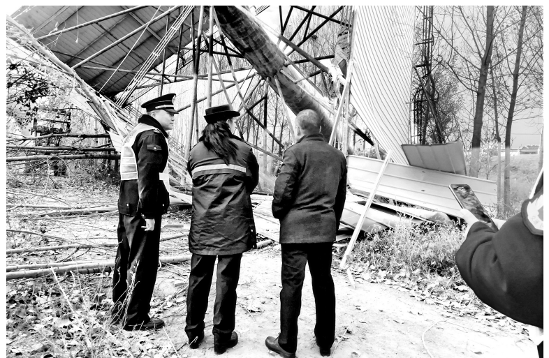
11月26日至28日,市交通运输执法局在高速路政、高速交警、汤阴县城管局共同配合下,先后对京港澳高速公路汤阴段两处大型违建广告塔实施拆除,彻底消除了高速公路通行安全隐患,净化了公路路域环境,保障了高速公路的安全畅通。(王振华 摄)
