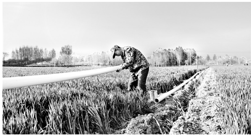
小型农田水利重点建设项目施工现场(资料图)
