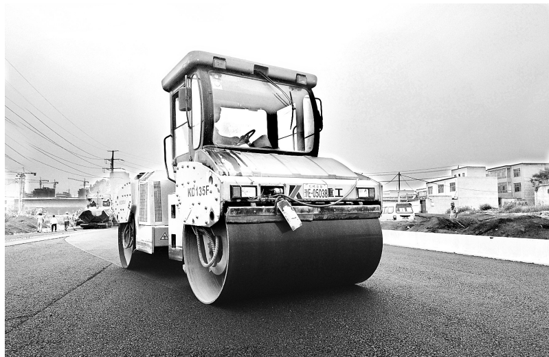
文峰大道东延工程施工现场
