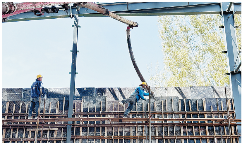
重庆宜欣纺织有限公司项目施工现场(侯文静 摄)
