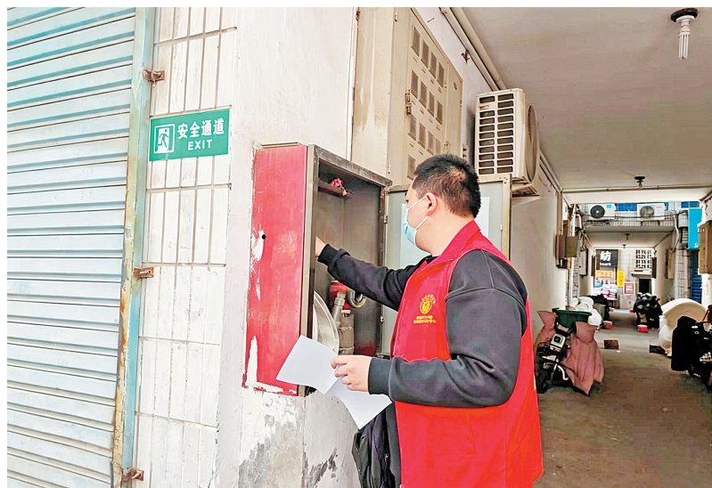
和平路社区网格员开展消防安全隐患排查
