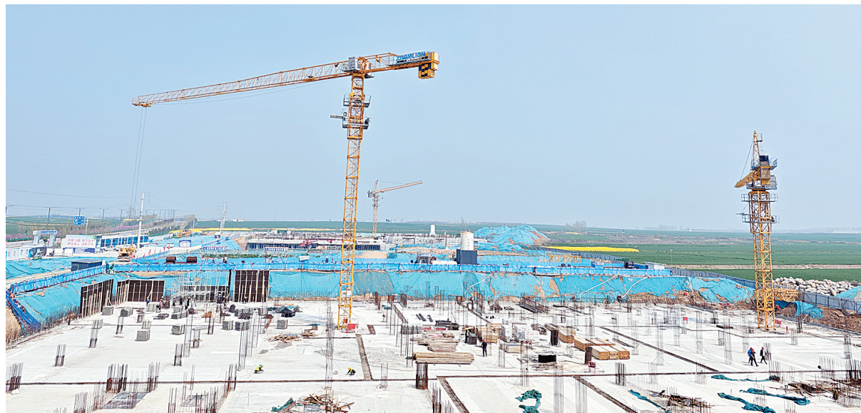
豫北航空经济协作区物流港项目二期工程施工现场(本报记者 牛思明 摄)
