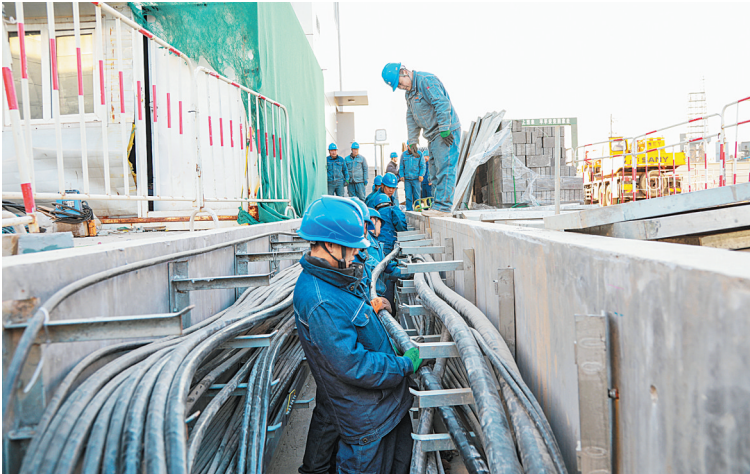
正在建设的220千伏铜冶输变电工程是我市西部电网的重要支撑,建成后将为安阳新型化工产业园区铜冶片区提供可靠电力保障。国网安阳供电公司将该工程列为今年重点建设项目全力冲刺推进。 图为12月5日,施工人员在变电站内敷设电缆。（本报记者 邓 娴）
