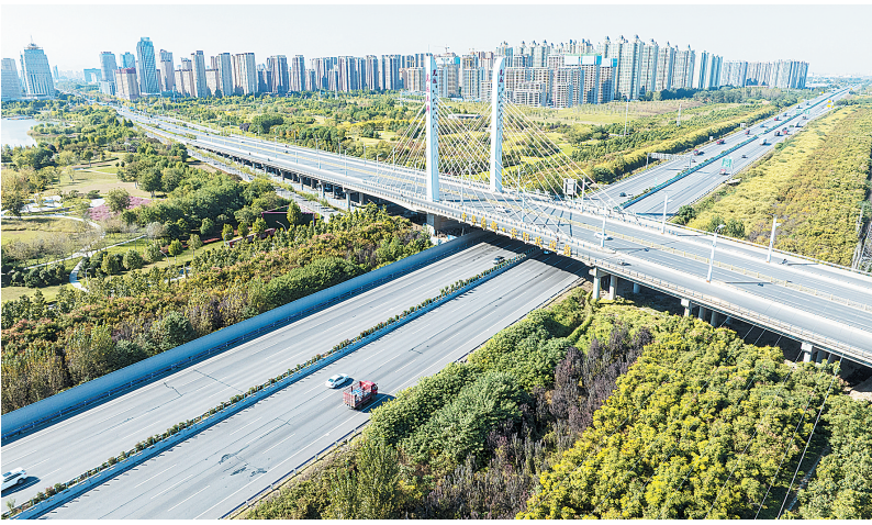
京港澳高速公路穿过安阳市区(本报记者 曲海庆 摄)
