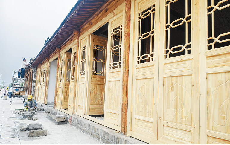
南大街街区修缮项目现场
