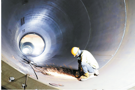
安阳机械工人在焊接作业(本报记者 郭有明 摄)
