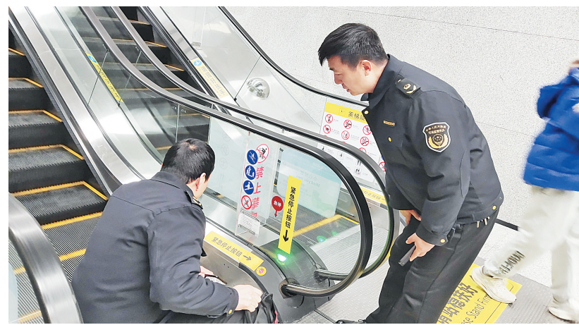
连日来,县市场监管局开展特种设备专项检查,加强特种设备安全管理,保障节日期间特种设备安全平稳运行。图为县市场监管局工作人员在检查高铁安阳东站内的电梯。(本报记者 姜蕴真/文 通讯员 王晏军/图)
