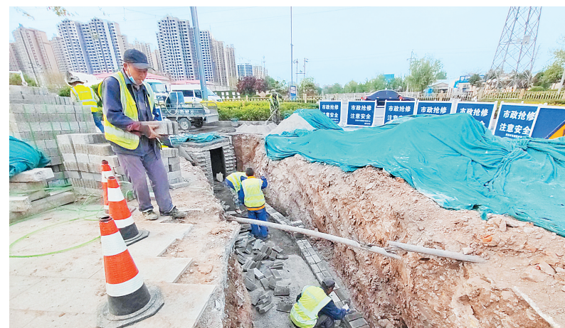
我市积水点改造施工现场(本报记者 高倩摄)
