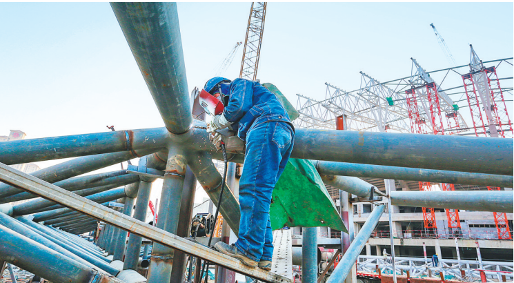
工人在焊接构件
