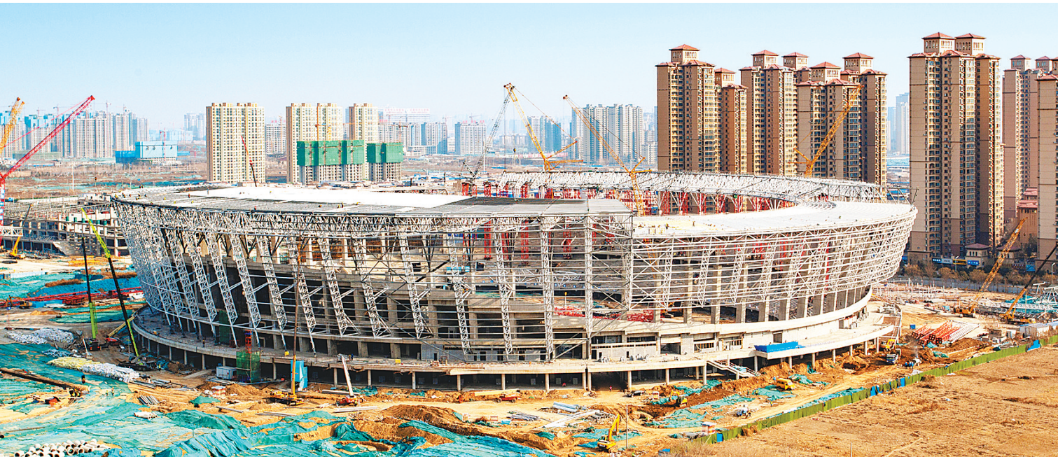
建设中的市文体中心体育场
