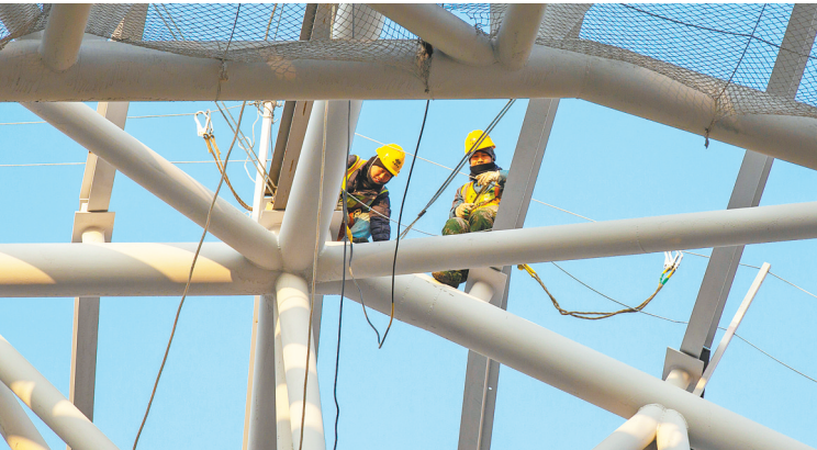
工人在50多米的高空作业
