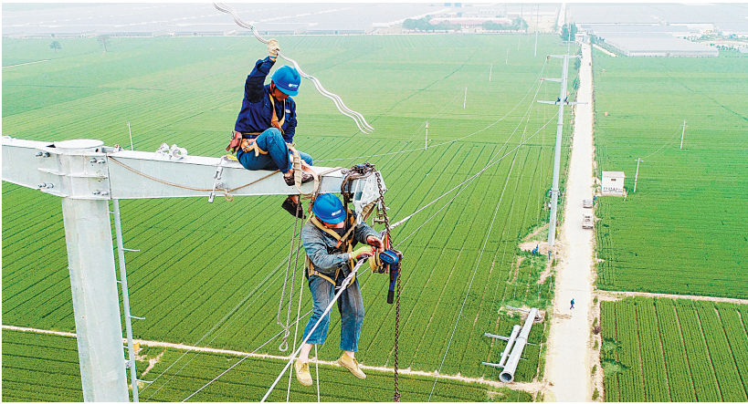
供电公司电力工人正在紧固导线(资料图)
