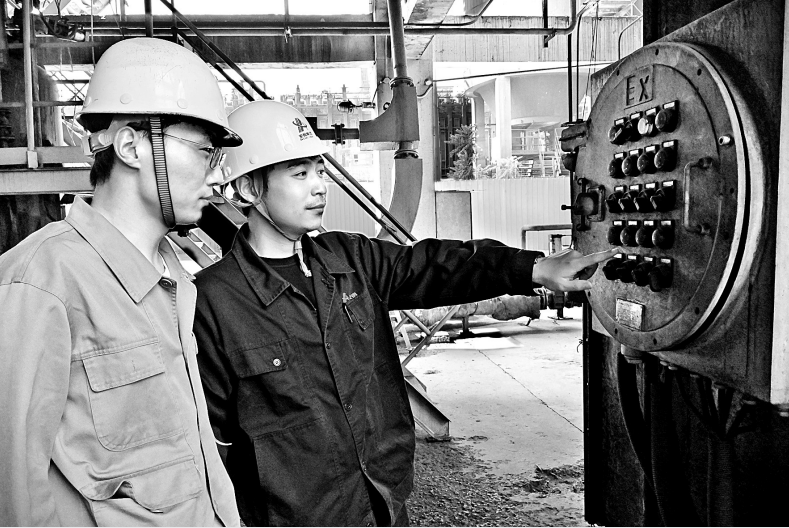
王毅(左)正在对安钢1#烧结机燃料除尘系统进行调试(本报记者 姚芳 摄)
