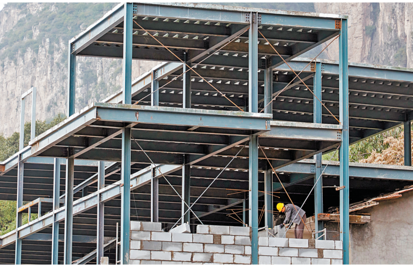
10月17日,在林州市石板岩镇上坪村上坪·云述民宿项目现场,工人正忙着砌墙。该项目是由上坪村农民专业合作社和郑州合志同创实业有限公司联合投资1000万元打造的文旅扶贫项目。项目运营后,预计村集体年增收8万元,群众户均年增收500元以上。(本报记者 江盟 摄)
